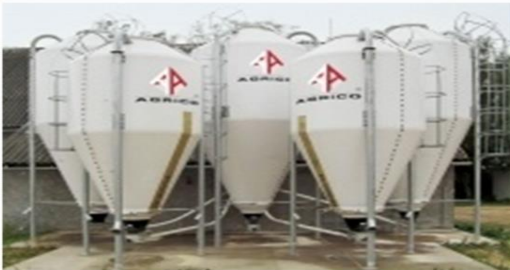
29-rasm. Yevropa fermerlari tomonidan qoʻllaniladigan steklolaminat don saqlash siloslari.
