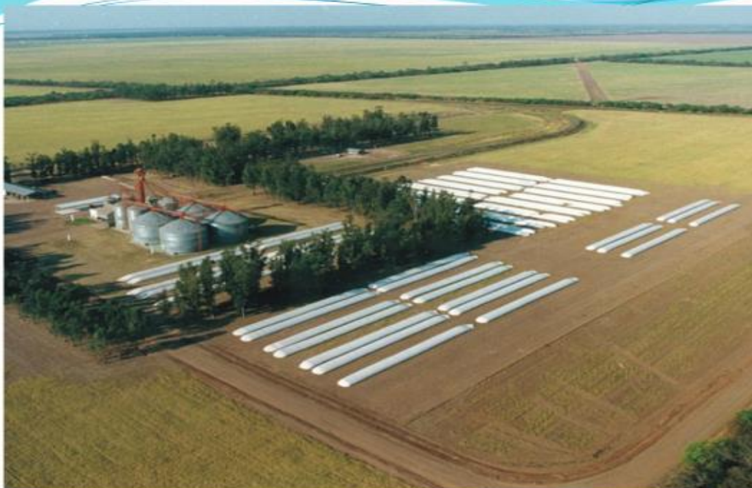
30-rasm. Dala sharoitida germetik usulda egiluvchan polietilen englarda don saqlash.
