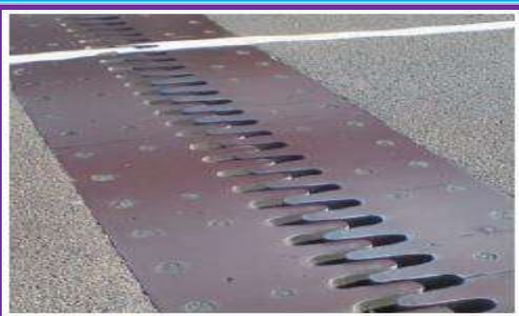
1.1-rasm. Ko'priknig ulangan qismining kengayishi. Eslatma: yo'ldagi oq chiziq bu shossening markazi.
