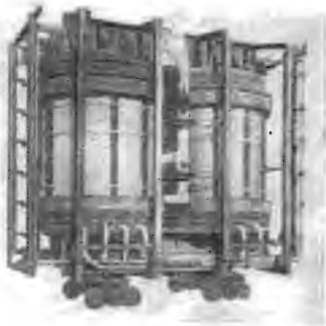
Рис. В-19. Активная часть автотрансформатора 100 Мв·а, 380 кВ фирмы «Альстом»
