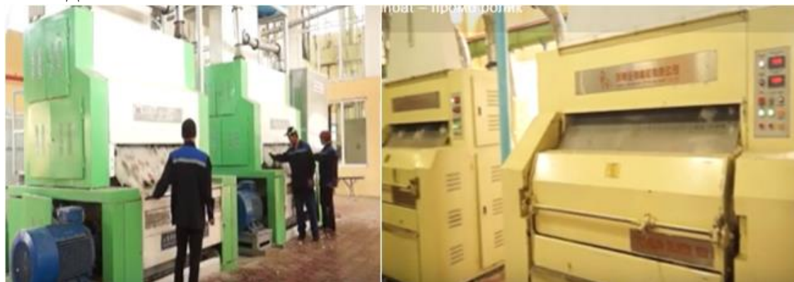
Фото 125, 126. Оборудование в хлопкоочистительных цехах.
