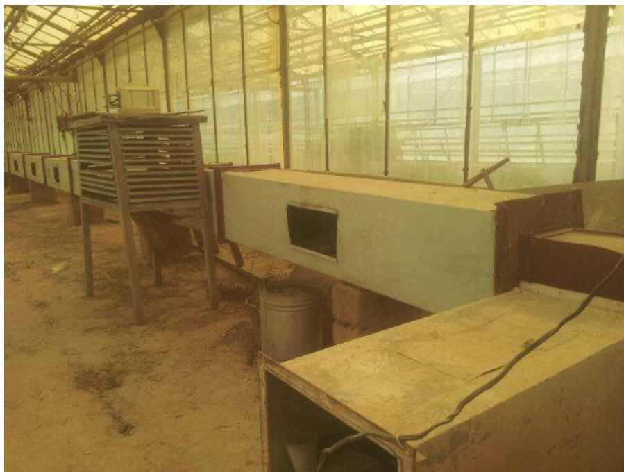
Фото 59. Части самодельной установки для подачи теплового ветра.
